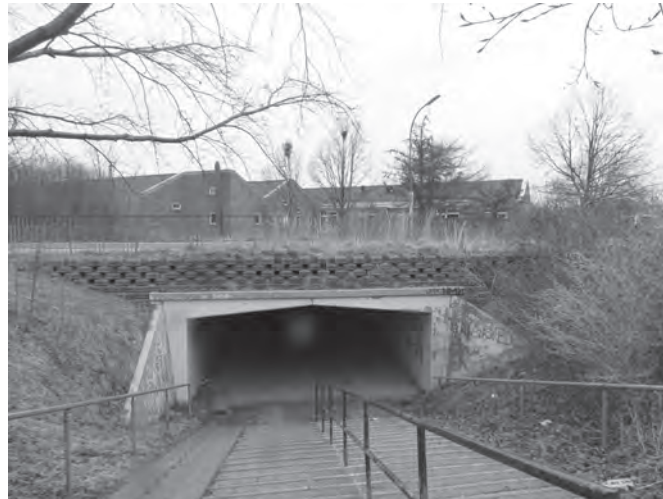
Tunnel under Bybjergvej
