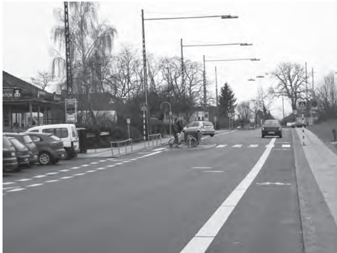
Fodgængerovergang på Bybuen ved Center Nord
